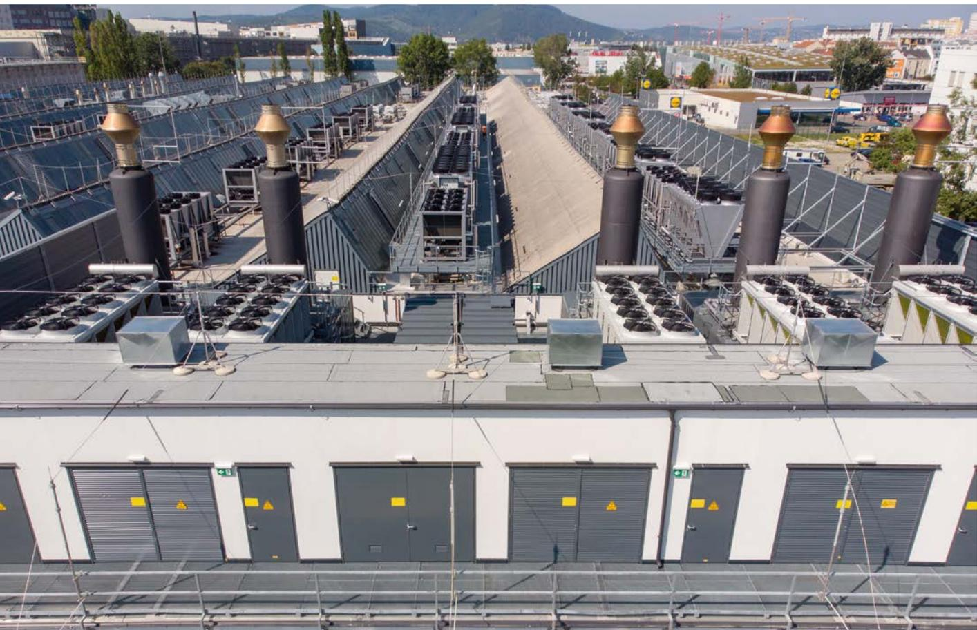
In der Klinik Floridsdorf sollen drei Wärmepumpen mit einer thermischen Nennleistung von insgesamt rd. 3 MW die Abwärme auf ein Temperaturniveau von max. 82 °C bringen. Die Wärme soll zur Teilversorgung der Klinik in das bestehende Wärmeverteilsystem eingespeist werden. Der bisher zur Versorgung des Krankenhauses genutzte Anschluss an das Fernwärmenetz der Wien Energie bleibt bestehen.
