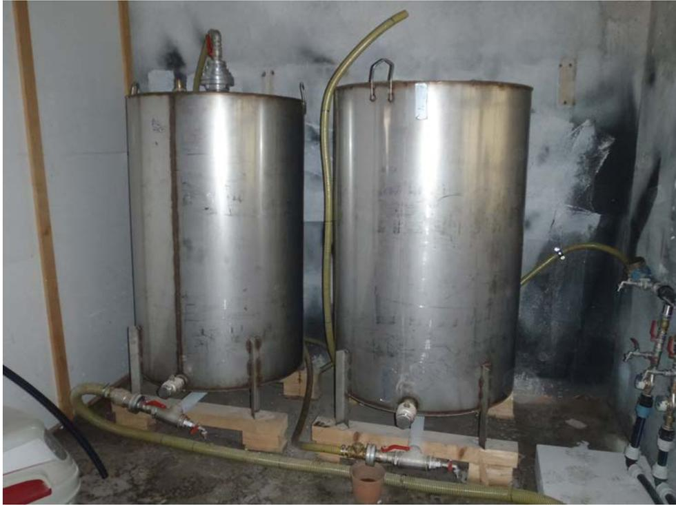
Grundwasserreinigungsanlage mit Aktivkohlefilter
